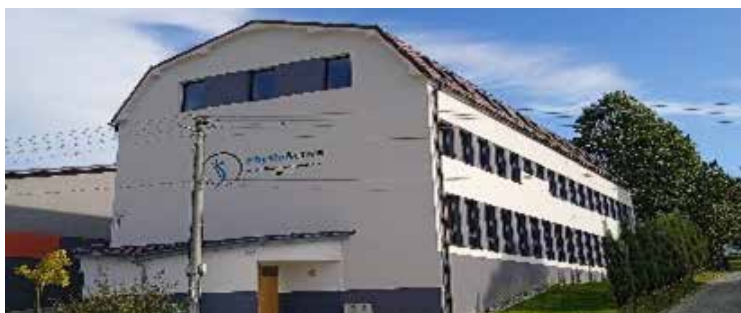
Projekt podporil z verejných zdrojov Fond na podporu umenia.
